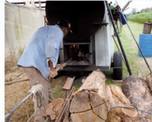
A lenha é o combustível para esquentar a água nas caldeiras
